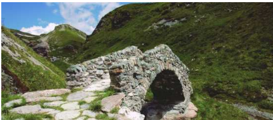
Steinbrücke am Septimerpass
